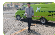
小型路面养护车 保洁作业
